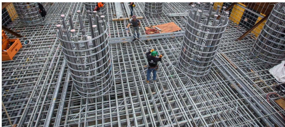
FIGURE 3.6 Utilisation d'armatures galvanisées dans les constructions en béton armé
