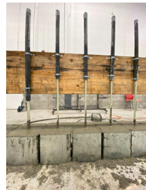
(d) Coulage du béton
